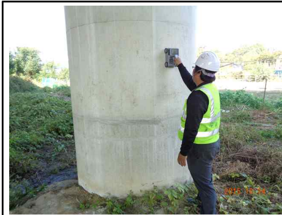
위 치 교각 내 용 철근탐사 시험
