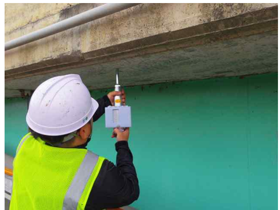
위 치 바닥판하면 내 용 반발경도 시험
