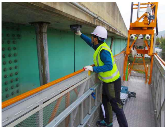
위 치 바닥판하면 내 용 철근탐사 시험
